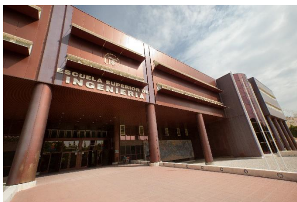
Escuela Técnica Superior de Ingeniería (ETSI) de la Universidad de Sevilla
