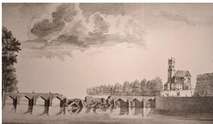
*Fig. 3. Puente del Mar sobre el Turia en Valencia, derruido por una crecida de finales del XVIII, según Cavanilles.*
